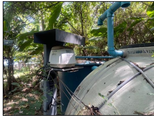
รูปที่ ค.1-4 ถังเกราะ
