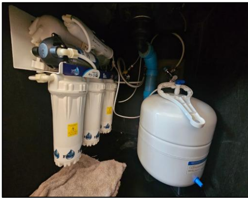
รูปที่ ค.1-13 การปรับปรุงคุณภาพน้ำด้วยถังกรองน้ำ
