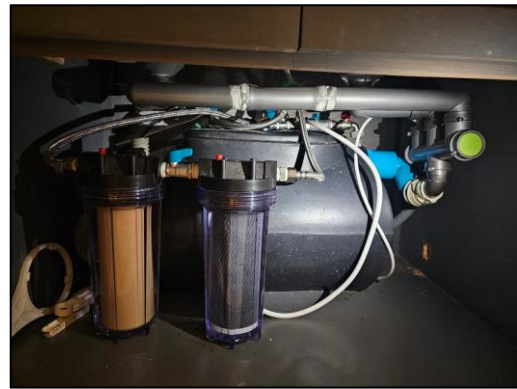
รูปที่ ค.1-13 การปรับปรุงคุณภาพน้ำด้วยถังกรองน้ำ
