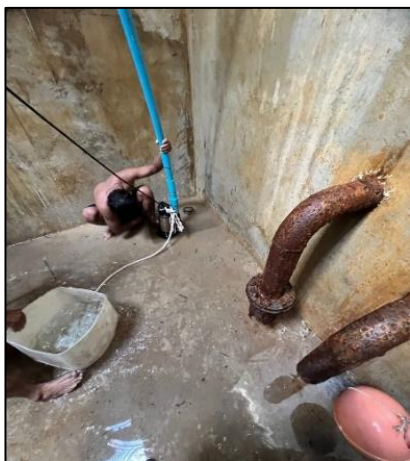
รูปที่ ค.1-10 การล้างทำความสะอาดถังเก็บน้ำใช้
