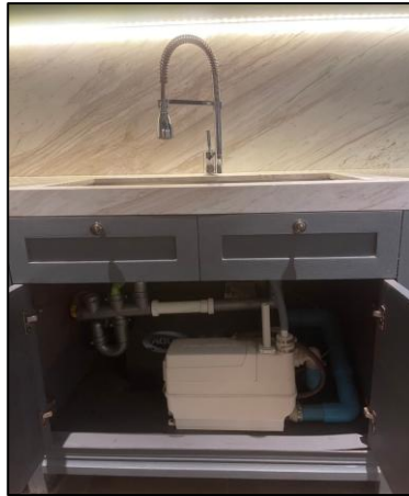
รูปที่ ค.1-12 ถังตกไขมันใต้อ่างล้างจาน
