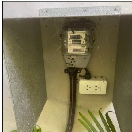
รูปที่ ค.1-14 มิเตอร์ไฟฟ้าสำหรับระบบบำบัดน้ำเสีย
